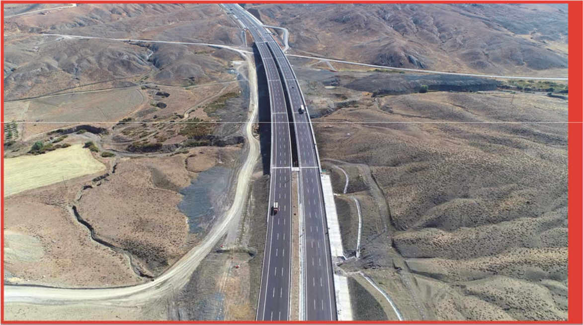
Km: 59+000 Derekişla Viaduct
